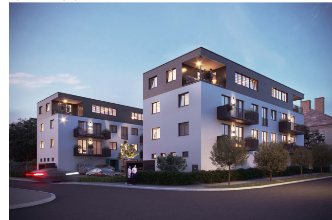
POHLED NA OBJEKT
