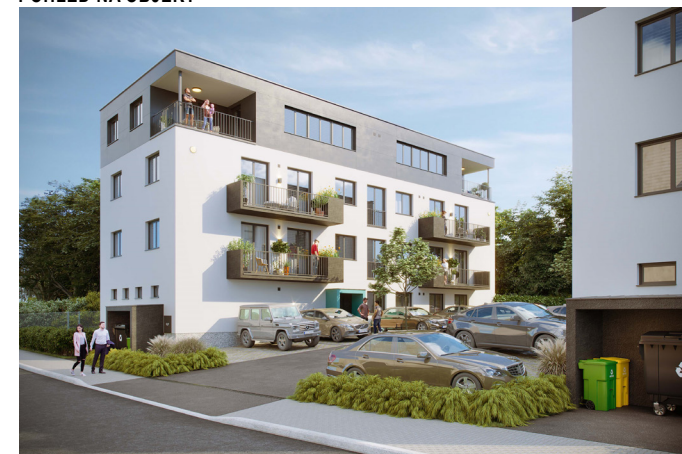
POHLED NA OBJEKT
