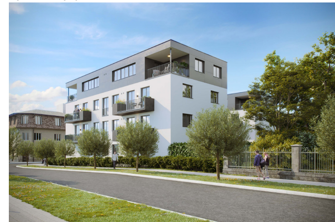
POHLED NA OBJEKT
