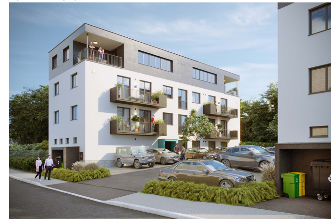
POHLED NA OBJEKT
