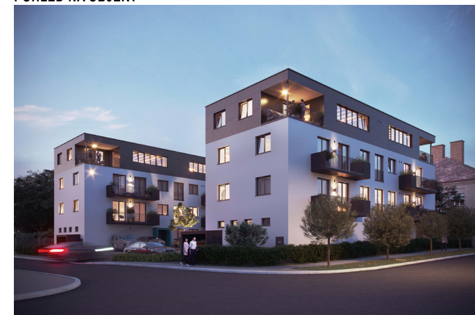
POHLED NA OBJEKT
